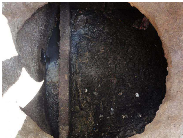
Figura 7.6. ETE Genibaú 40 – Calha do filtro obstruída
