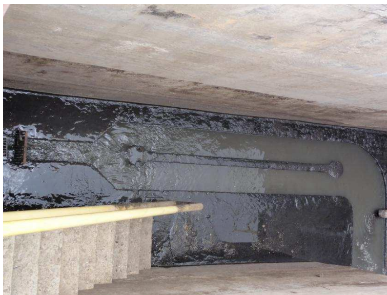
Figura 7.1. EE Souza Pinto - Gradeamento e caixa de areia afogados
