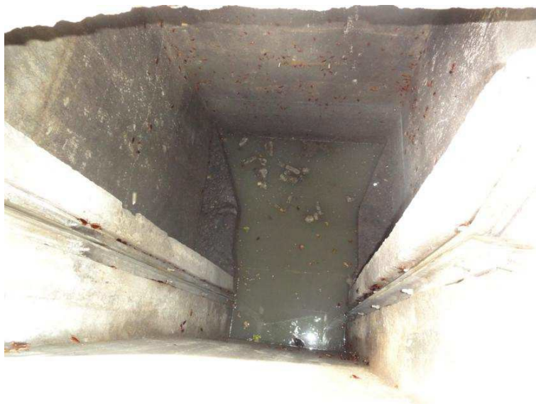
Figura 7.2. EE Parque Rio Branco – Gradeamento afogado
