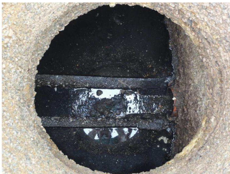
Figura 7.5. ETE Campo dos Ingleses 01 - Ausência de manutenção
