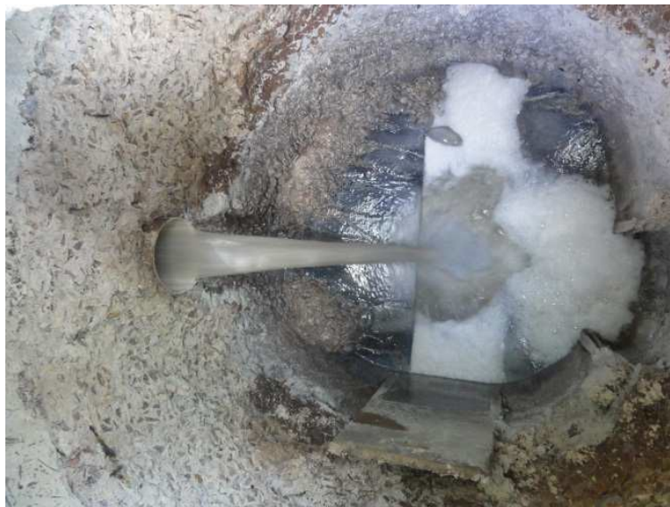
Figura 7.13. ETE Conj. Paupina – Saída do efluente com bastante escuma.
